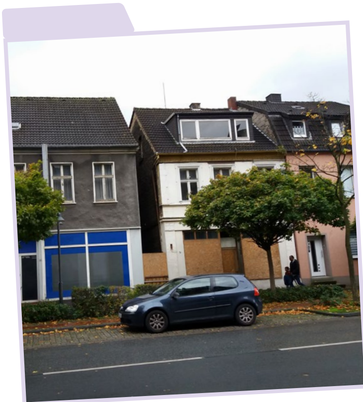
Problemimmobilien in Hamm
