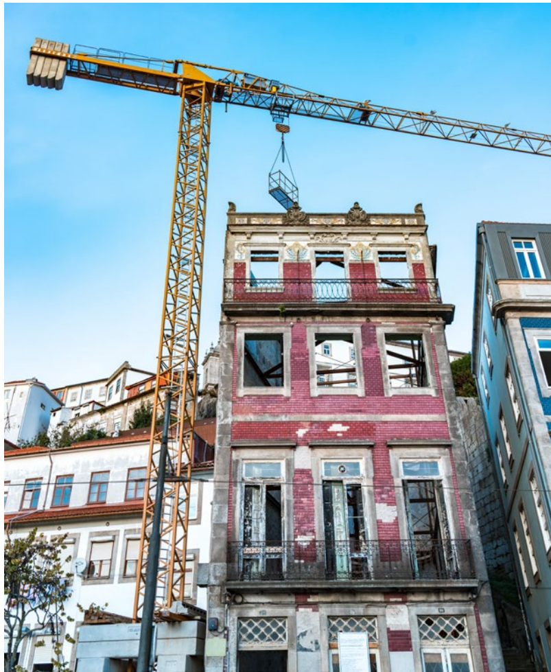
Rückbau einer Problemimmobilie
