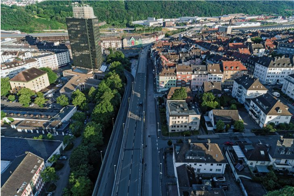
Die Brücke von „oben“. (Fotos: Andreas Kohl)
