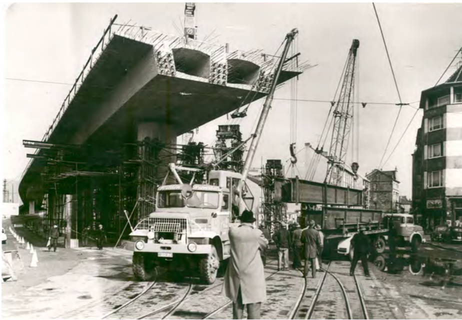
Stop of Construction „Sprungschanze“, 1964.
